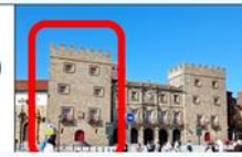
POR ÚLTIMO SE CONSTRUYÓ ESTA TORRE.
